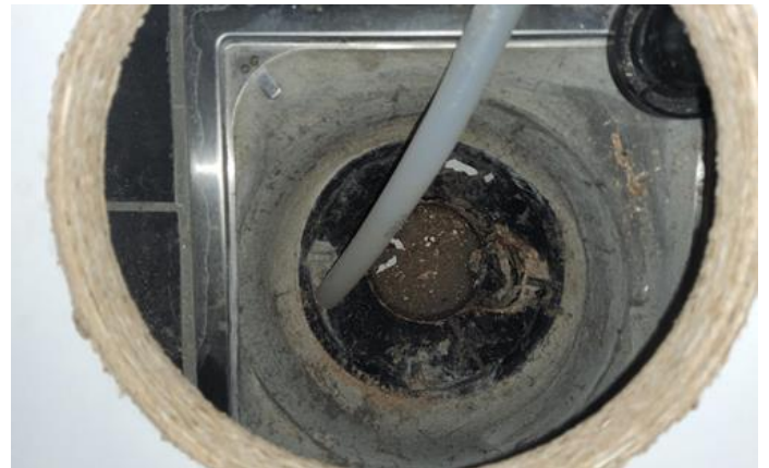
Membran, tettesjikt og overgang til sluk. - [Sluk vaskerom ]
