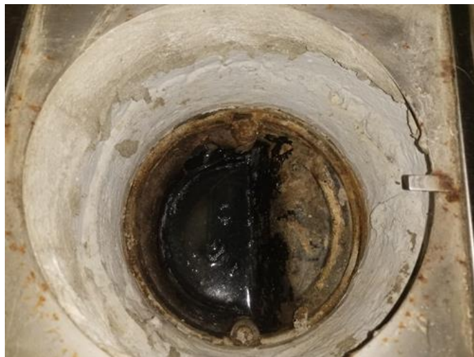
Membran, tettesjikt og overgang til sluk. - [Sluk bad under servant.]
