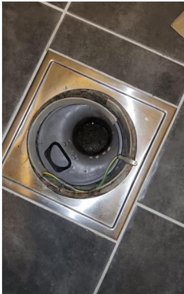
Avløpsrør (ink. sluk) - [Sluk på bad]
