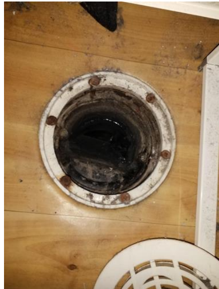
Membran, tettesjikt og overgang til sluk. - [Sluk vaskerom.]
