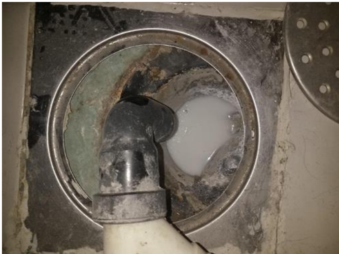
Våtrom - [Sluk bad.]
