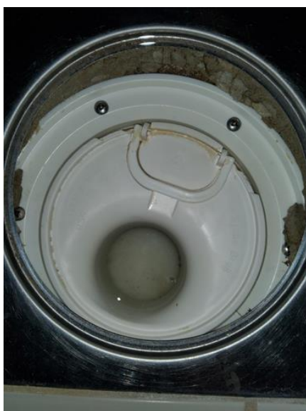
Våtrom - [Sluk bad]
