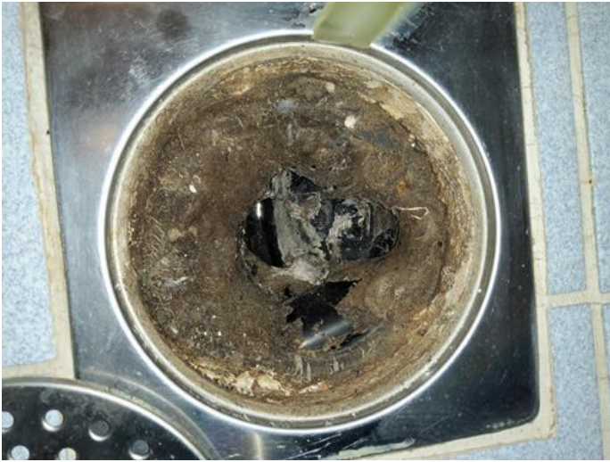
Membran, tettesjikt og overgang til sluk. - [Sluk badrom 2.etasje ]
