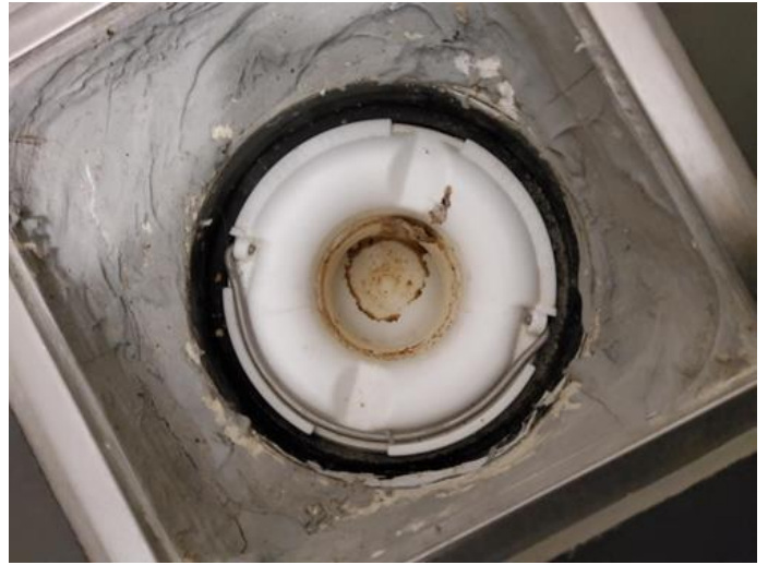
Membran, tettesjikt og overgang til sluk. - [Sluk baderom 1.etasje ]
