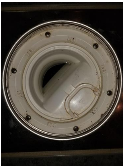
Membran, tettesjikt og overgang til sluk. - [Sluk bad kjeller.]
