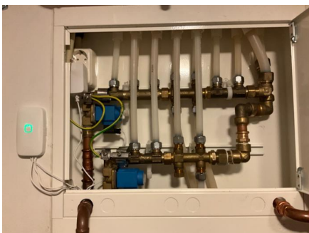
Koblingskap for vannrør
