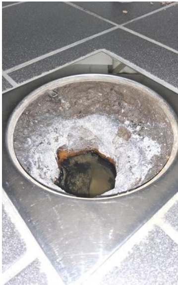
Avløpsrør (ink. sluk) - [Sluk på vaskerom]
