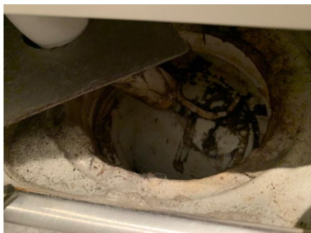
Baderomssluk i kjelleren, plassert delvis under dusjkabinett.
