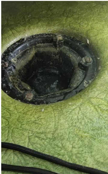
Avløpsrør (ink. sluk) - [Sluk på bad]
