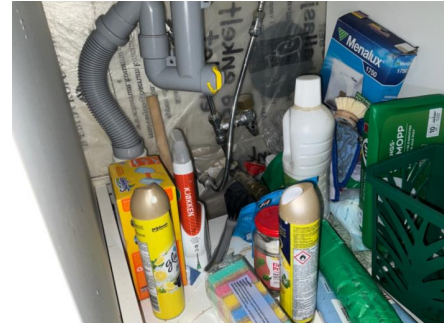
Opplegg i kjøkken benk
