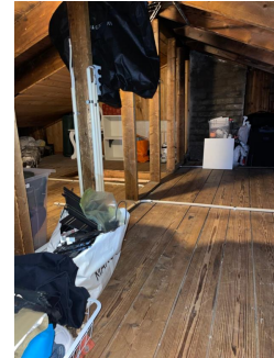
Vegg inn mot naboloft bør brannsikres.
