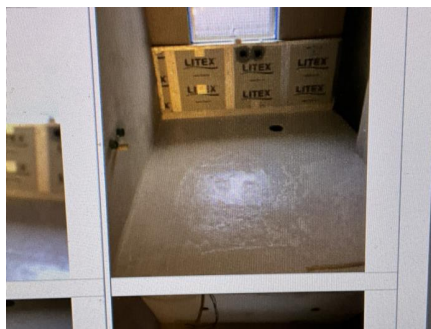
Bilde av gulvmembran fra da badet ble bygget
