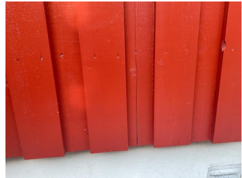
Oppsprukket bordkledning.
