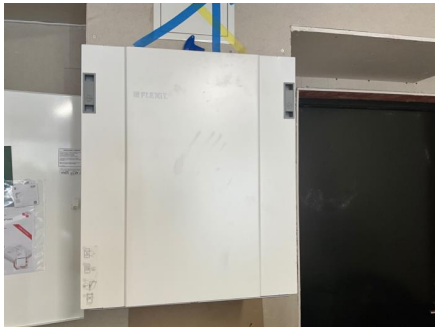
Ventilasjonsaggregat er i garasje
