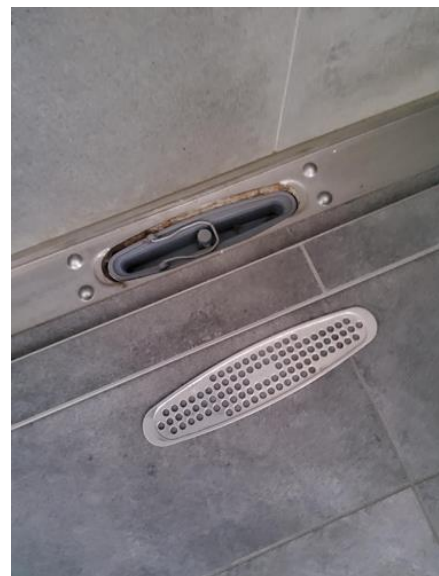
Membran, tettesjikt og overgang til sluk. - [Sluk Baderom. ]
