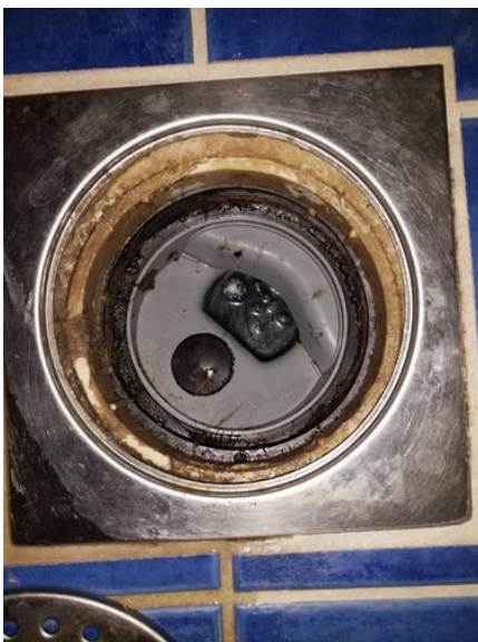
Membran, tettesjikt og overgang til sluk. - [Sluk bad utleiedel ]
