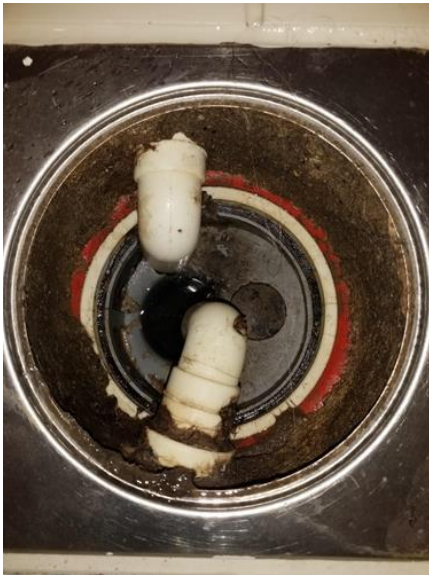
Membran, tettesjikt og overgang til sluk. - [Sluk bad 2.etasje ]
