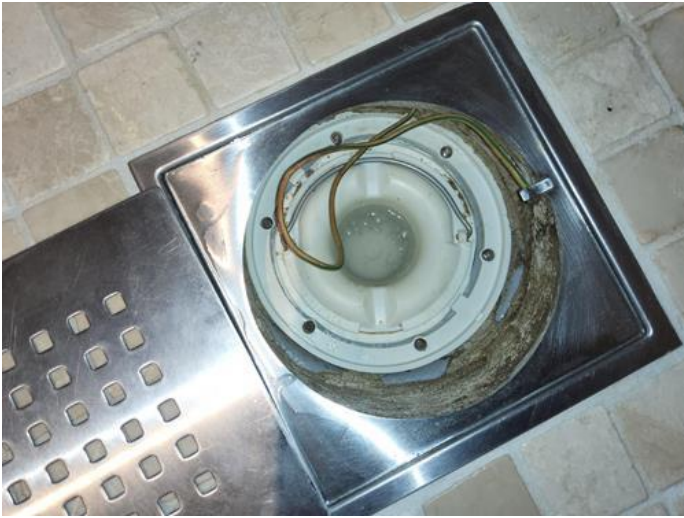
Membran, tettesjikt og overgang til sluk. - [Sluk]
