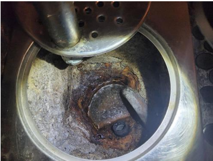
Membran, tettesjikt og overgang til sluk. - [Sluk vaskerom ]
