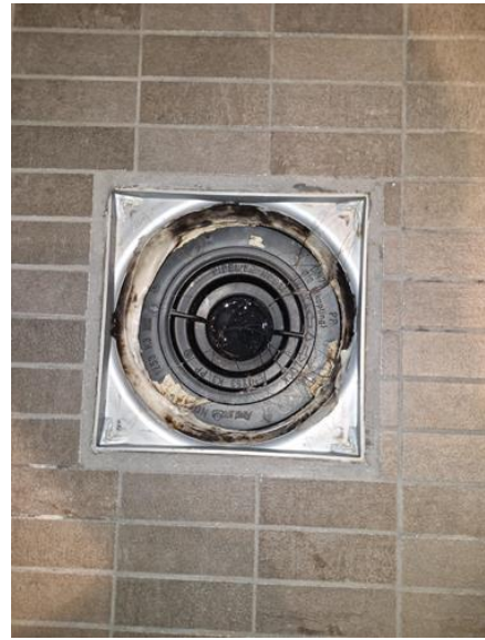
Våtrom - [Bad 1. etasje]
