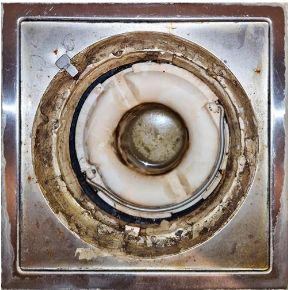
Våtrom - [Bad 2. etasje]
