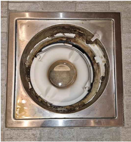
Våtrom - [Bad underetasje]
