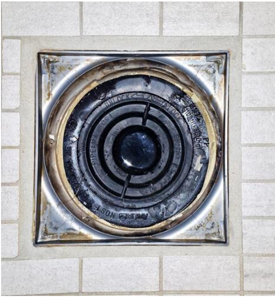
Våtrom - [Bad utleiedel]
