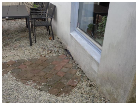
Noe synlig grunnmursplast på tilbygd del.
