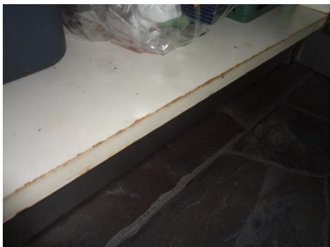
Slitt skrog i skap under vask.
