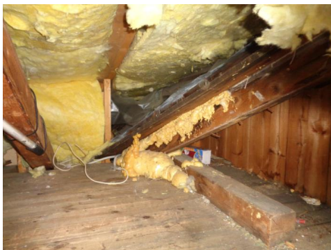
Noe eldre tresperr i bygget.
