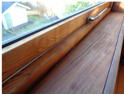
Mellomrom mellom foringer og karmen.
