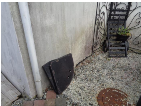
Noe synlig grunnmursplast på tilbygd del.
