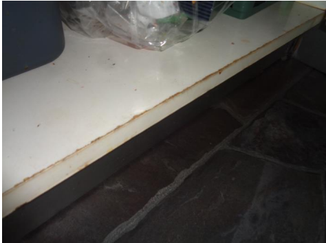
Slitt skrog i skap under vask.
