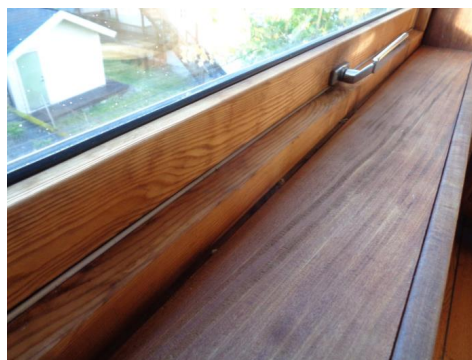
Mellomrom mellom foringer og karmen.
