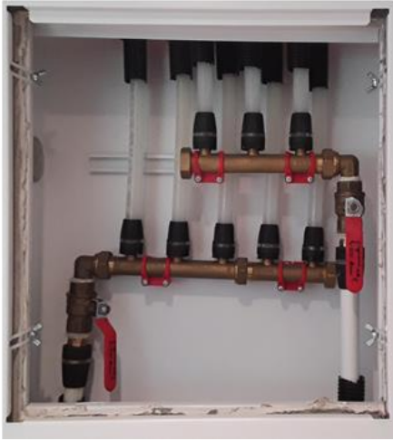
Tekniske anlegg, VVS anlegg (Sjekkpunkter utover det som er inkludert i andre rom) - [Fordelerskap til rør-i-rør system - Bad underetasje]
