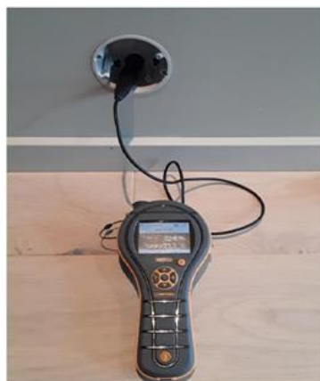
Våtrom - [Hulltaking og fuktmåling fra tilstøtende rom til bad, loftsetasje - Soverom]
