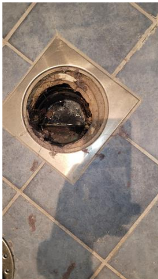
Våtrom - [Sluk bad.]
