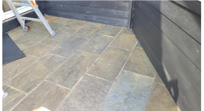
Utvendig - [Kledning har liten avstand fra platting.]
