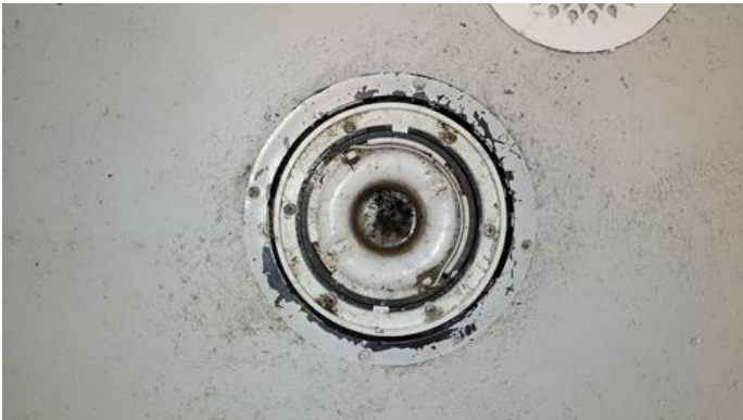
Våtrom - [Sluk vaskerom.]
