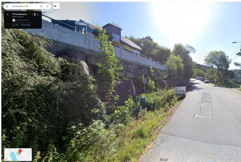
Figur 1 Ture Neumans vei 83 sett fra kommunal vei. Kilde: https://www.google.com/maps
