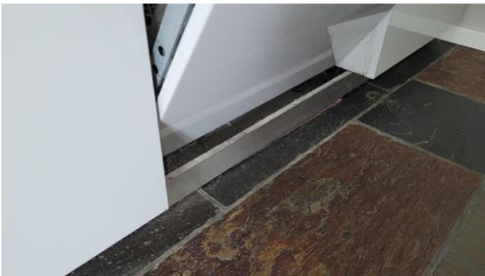
Kjøkken - [Oppvaskemaskin tar borti sokkellist når den åpnes.]
