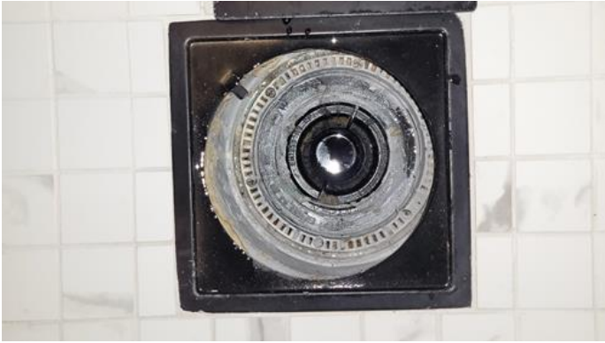
Våtrom - [Sluk bad.]
