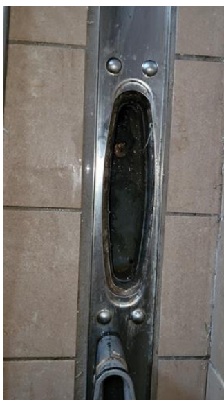
Våtrom - [Sluk bad.]
