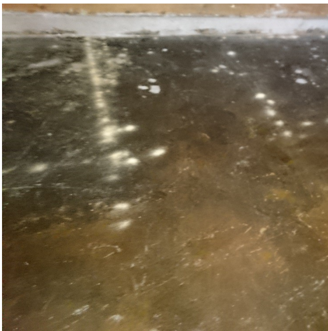
Spor etter boremel fra Stripet boorebille i taksperrer
