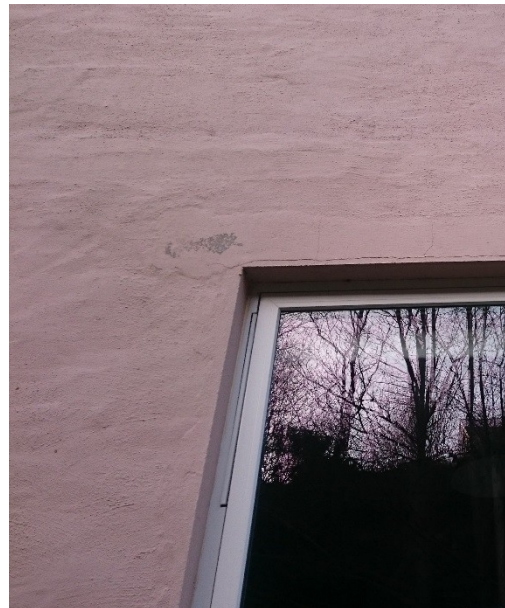
Sprekk over kjøkkenvindu
