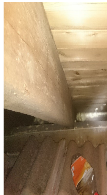
Tetting av lufting i raft med byggsaum
