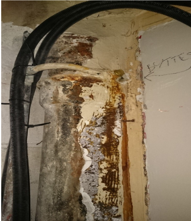
Eksisterende avløp og vannrør som er støpt inn på bad
