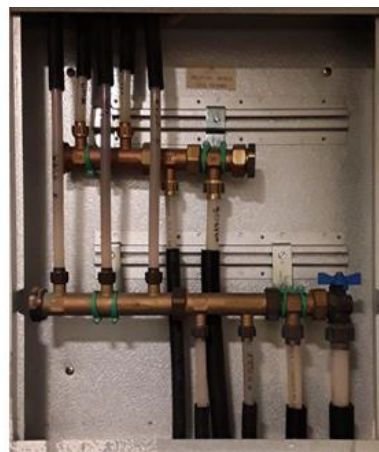
Tekniske anlegg, VVS anlegg (Sjekkpunkter utover det som er inkludert i andre rom) - [Rør-i-rør fordelerskap - Vaskerom]
