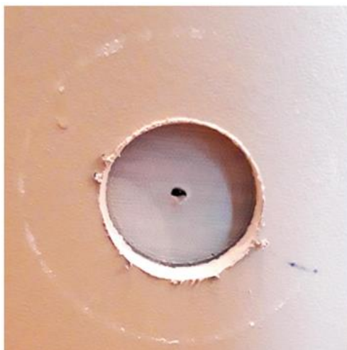
Rom under terreng (kjeller, underetasje, sokkeletasje) - [Hulltaking i rom under terreng - Fuktsperre-fuktbremse inne i vegg]
