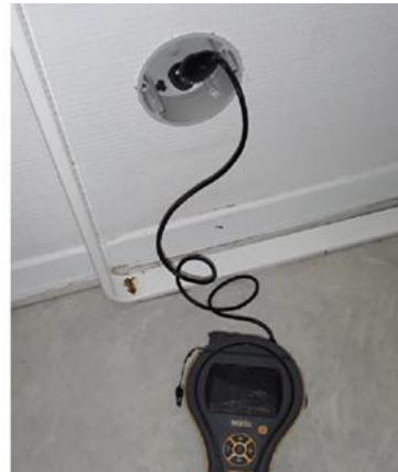
Våtrom - [Hulltaking og fuktmåling fra tilstøtende rom til bad - Bod]
