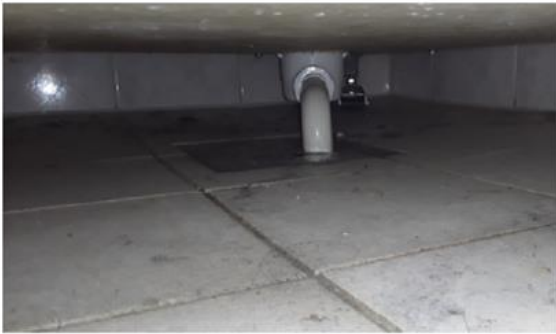
Våtrom - [Sluk under dusjkabinett - Baderom]
