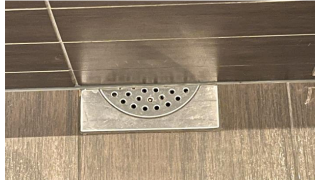
Sluk som er delvis skjult under badekar
