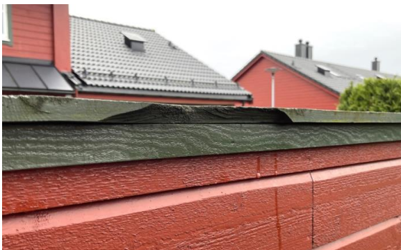
Skade/svinn på toppbord
