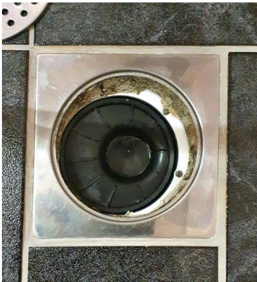
Våtrom - [Bad 1. etasje]
