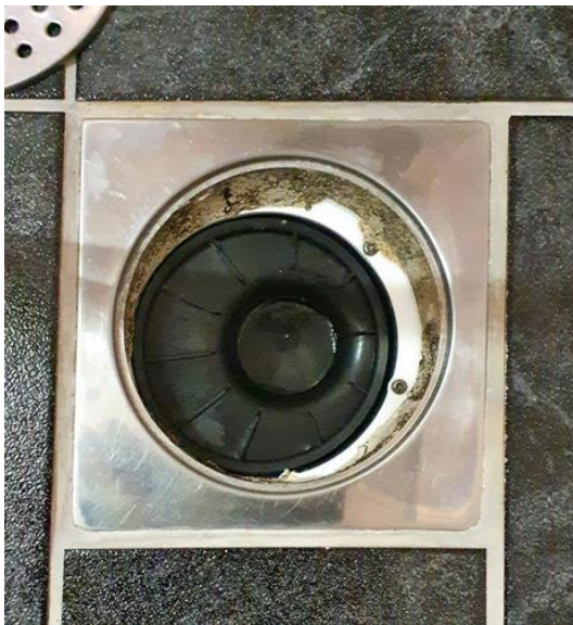
Våtrom - [Bad 1. etasje]
