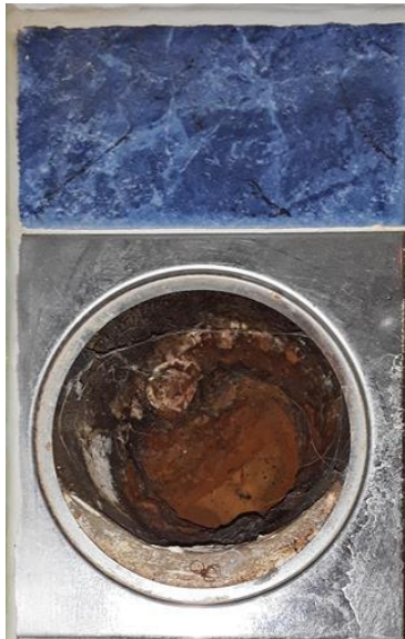
Våtrom - [Sluk bad]
