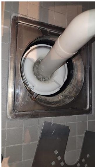
Våtrom - [Sluk bad.]
