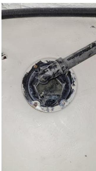
Våtrom - [Sluk vaskerom underetasje.]
