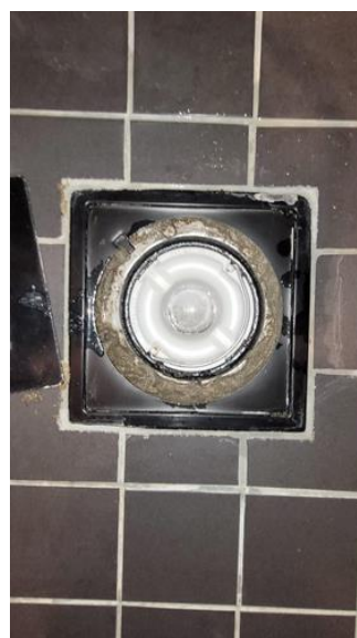
Våtrom - [Sluk bad 1. Etasje]
