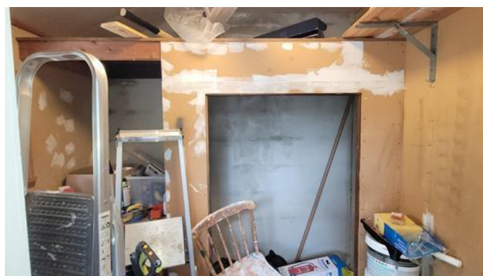
Utvendig - [Fuktmerker på på vegg i utvendig bod.]
