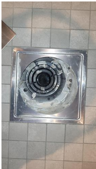
Våtrom - [Sluk bad 1. Etasje.]
