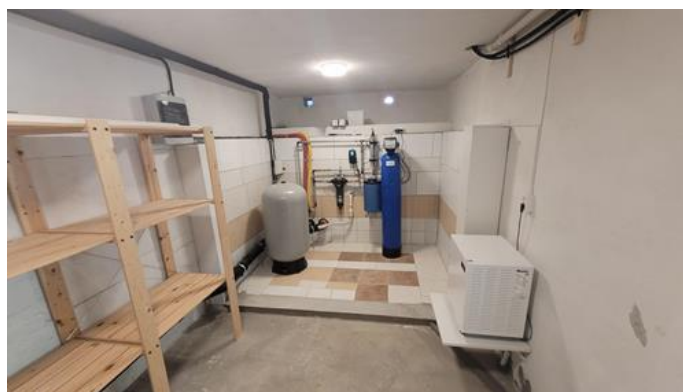
Utvendig - [Trykktank og vannfilter.]
