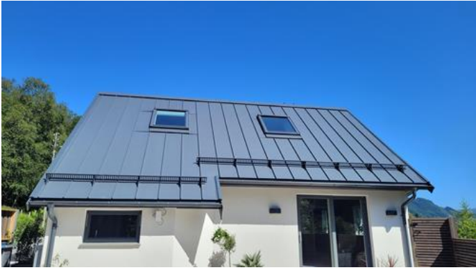
Utvendig - [Oversiktsbilde tak.]
