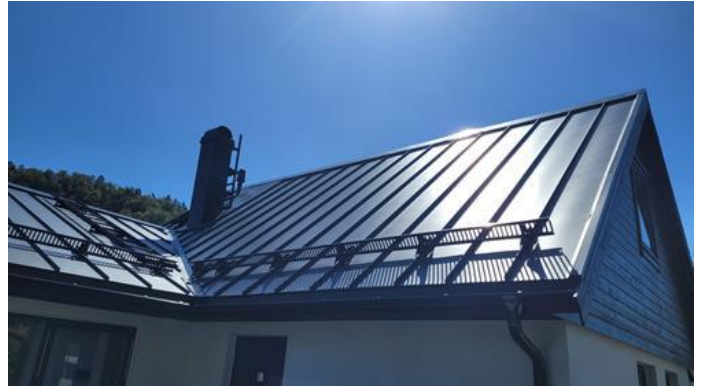
Utvendig - [Oversiktsbilde tak.]
