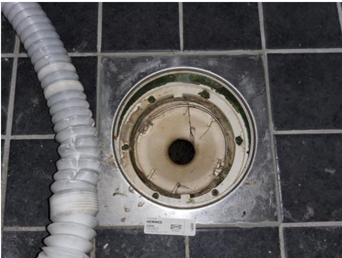
Våtrom - [Sluk på baderommet ]
