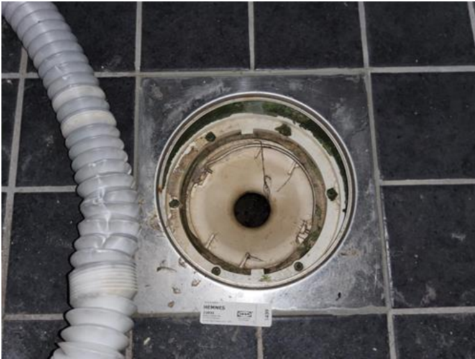
Våtrom - [Sluk på baderommet ]
