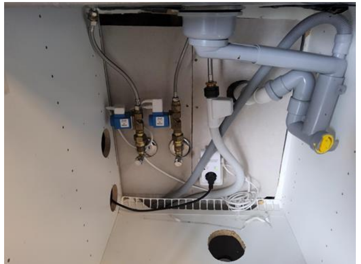
Kjøkken - [Vannrør i benkeskap kjøkken.]
