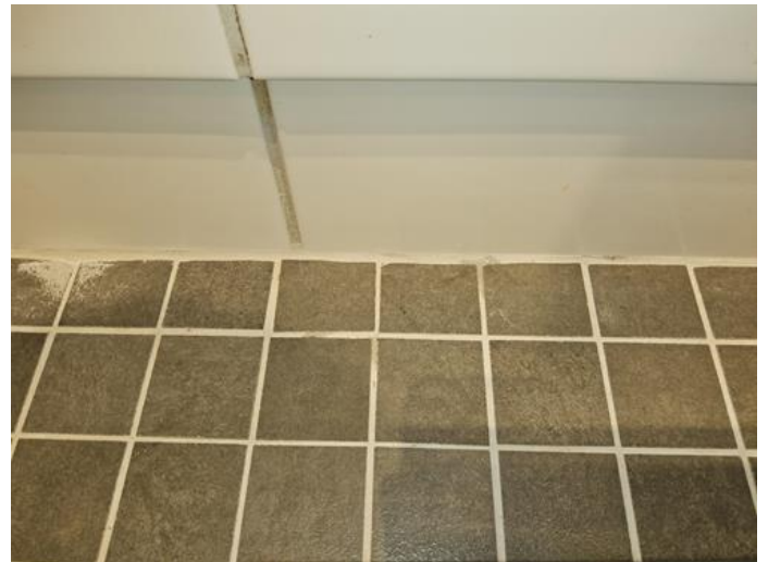
Kommentar - [sementfuge, og ikke elastiske fuger mellom gulv og veggflis]
