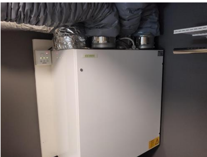
Tekniske anlegg, VVS anlegg (Sjekkpunkter utover det som er inkludert i andre rom) - [Ventilasjonsagregat plassert i
