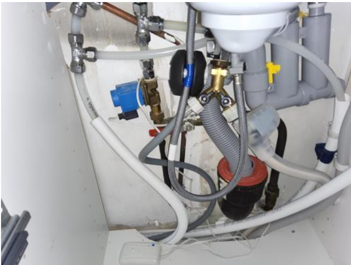
Hovedstoppekran - [Hovedstoppekran er plassert i benkeskap kjøkken.]
