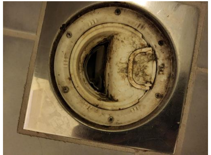
Slukets tilkomstmulighet for rengjøring - [Hjelpesluk bad.]
