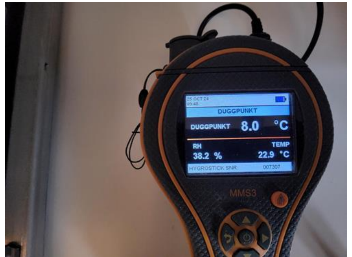
Fukt i tilliggende konstruksjoner - [Fuktmåling bad.]
