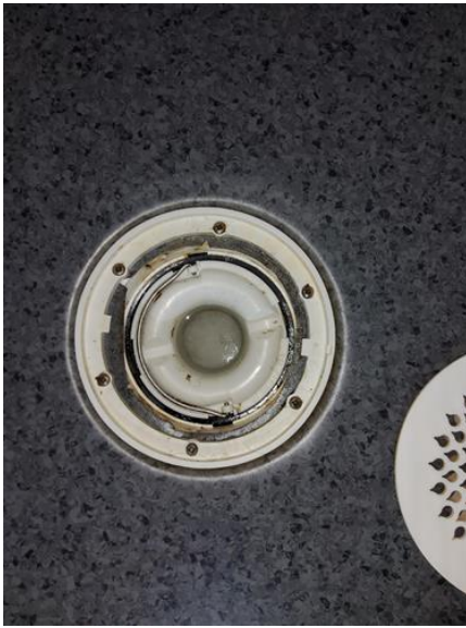
Membran, tettesjikt og overgang til sluk. - [Sluk Baderom loftsetasje.]
