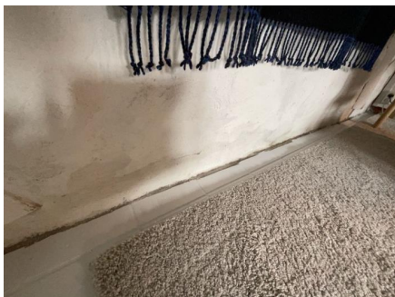
Fuktutslag med Protimeter fuktapparat.
