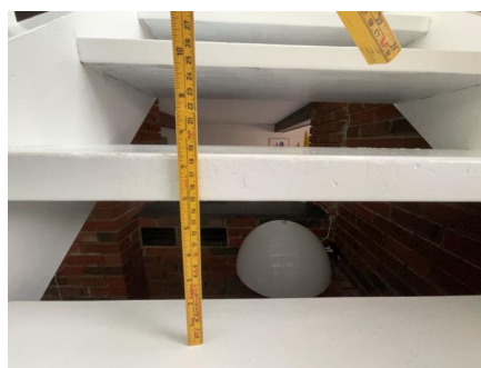
Åpninger mellom trinn er ca. 15cm.
