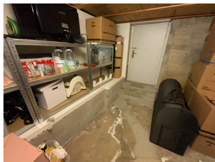
Leca grunnmur (kant) på innside av opprinnelig grunnmur.
