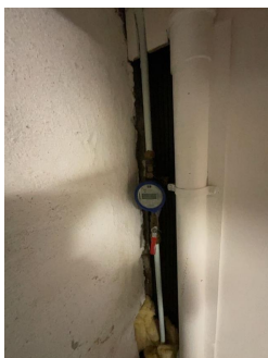
Stoppekran. Nyere forbruksmåler.
