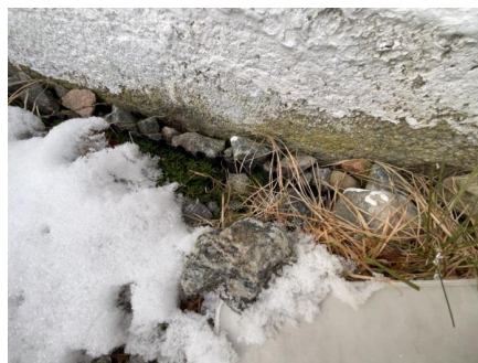
Grunnmurspapp ligger under terreng.
