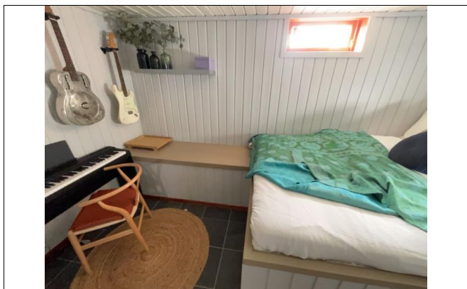
Innkassing langs grunnmur i kjeller er ikke undersøkt nærmere da det krever inngrep i konstruksjonen. Det opplyses å være synlig fjell bakenfor. Ikke kontrollert av takstmann.
