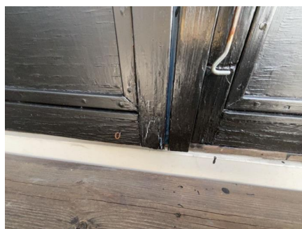
Sprekkdannelse/råte.
