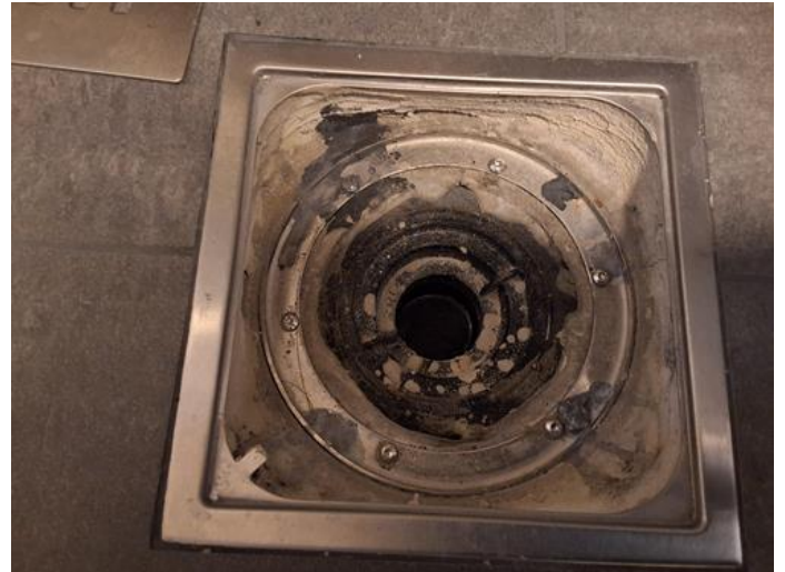
Våttrom - [Sluk på vaskerom]
