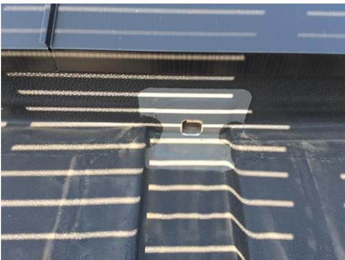
Utvendig - [Overløp på tak]
