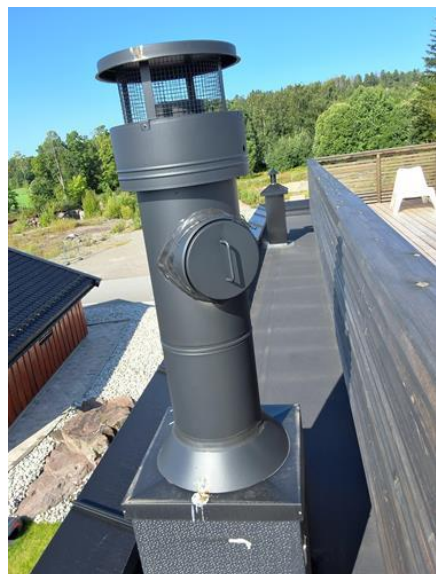
Utvendig - [Pipe over tak]
