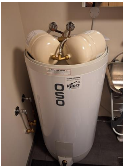
Tekniske anlegg, VVS anlegg (Sjekkpunkter utover det som er inkludert i andre rom) - [VVB på vaskerom]
