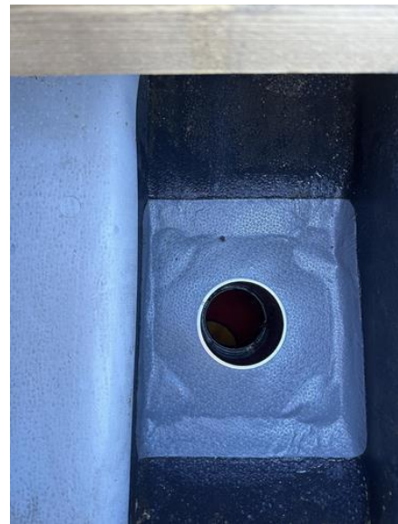
Utvendig - [Sluk på tak]
