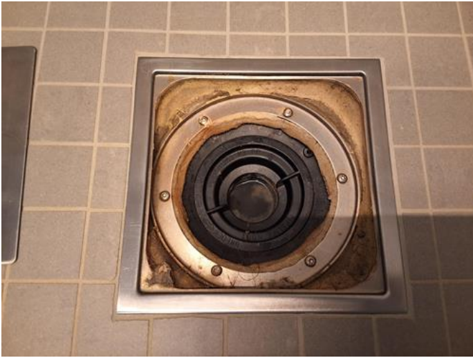
Våttrom - [Sluk på bad 2. etasje]
