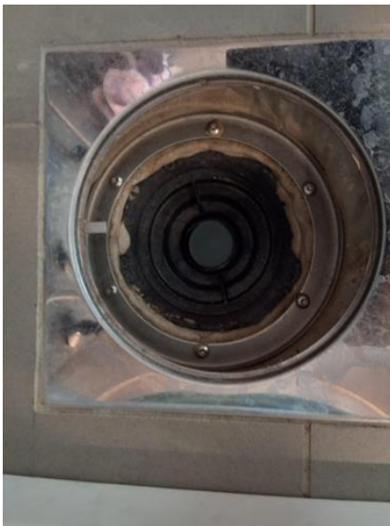
Våttrom - [Sluk 2 på bad 1. etasje]
