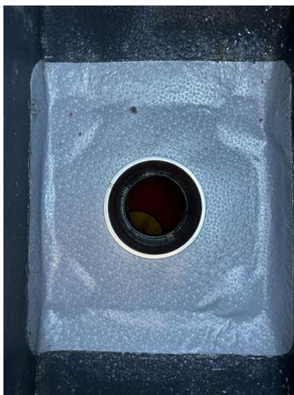
Utvendig - [Sluk på tak]
