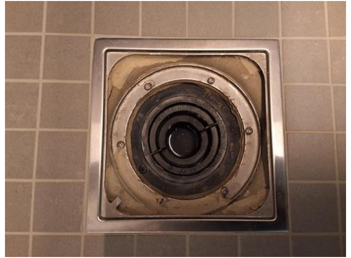
Våttrom - [Sluk på bad 1. etasje]
