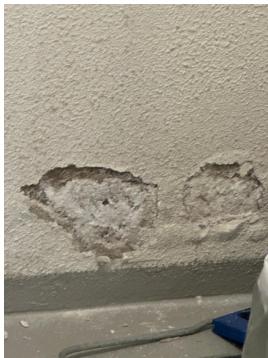
Utvendig riss/sprekk i grunnmur
