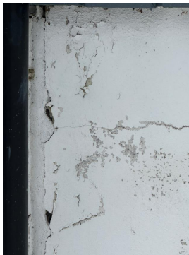
Utvendig riss/sprekk i grunnmur
