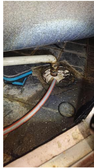
Membran, tettesjikt og overgang til sluk. - [Sluk Baderom U.etasje.]
