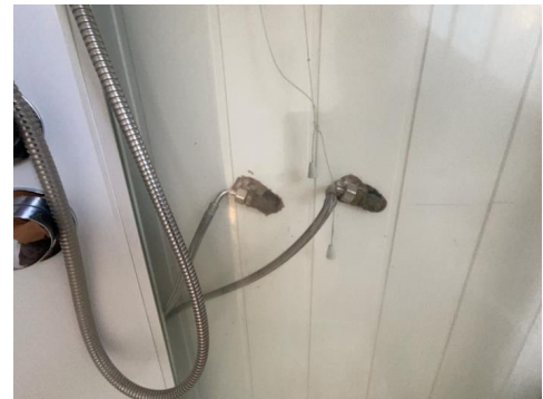
Utette rørkoplinger våtsone
