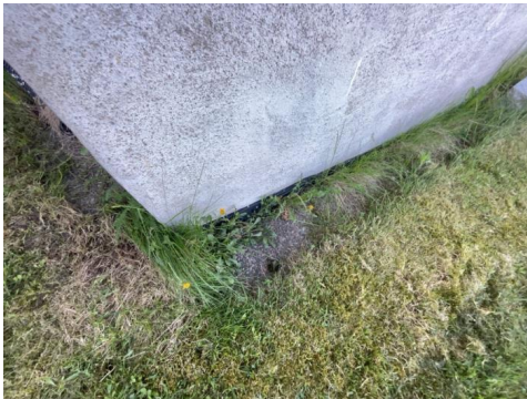
Stedvis synlig fuktsperre (eldre variant m/riller)
