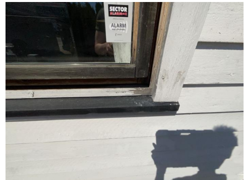
Vindu kjøkken 2.etg. stenger ikke i toppen
