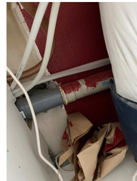
Nytt avløpsrør kjøkken grenet inn på gammelt avløp fra byggeår.
