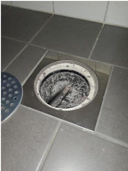
Membran, tettesjikt og overgang til sluk. - [Hjelpesluk Bad/vaskerom, under innredning.]
