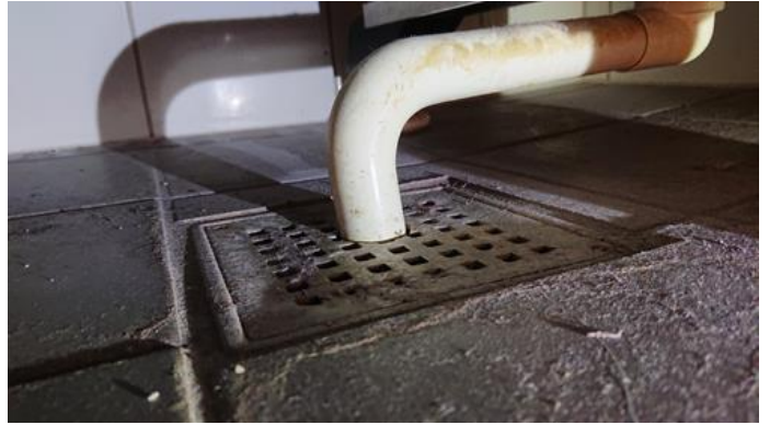
Membran, tettesjikt og overgang til sluk. - [Sluk Bad/vaskerom, under badekar. ]
