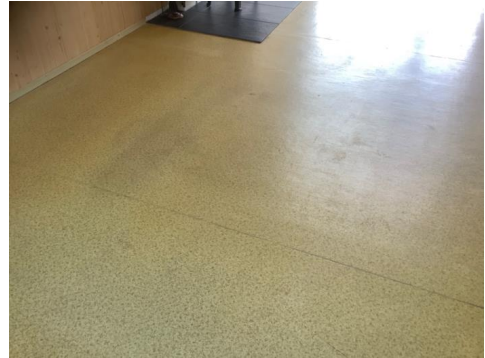
Innvendige overflater for det meste fra byggeår.
