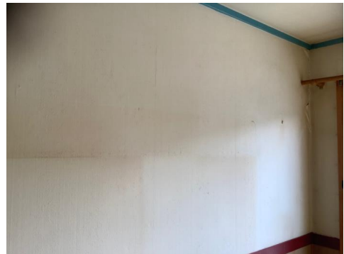
Innvendige overflater for det meste fra byggeår.
