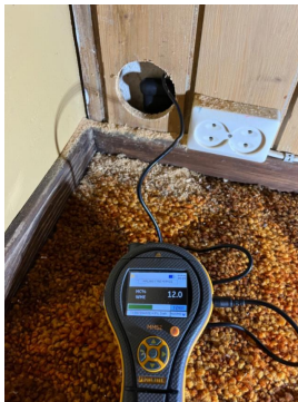
Hulltaking utforet vegg i kjellerstue. Ingen skadelig fukt påvist.
