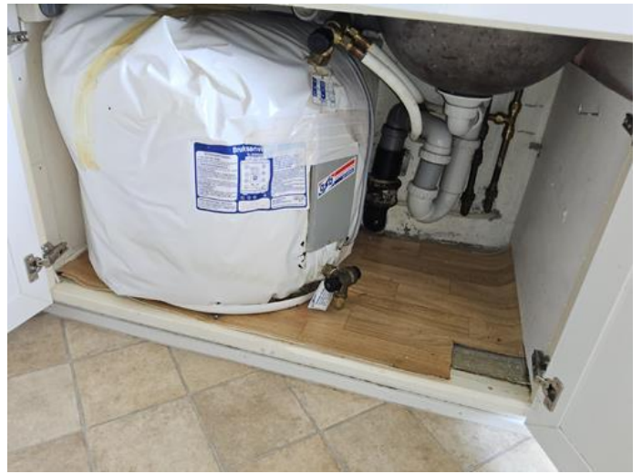
Tekniske anlegg, VVS anlegg (Sjekkpunkter utover det som er inkludert i andre rom) - [VVB]
