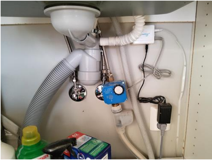
Tekniske anlegg, VVS anlegg (Sjekkpunkter utover det som er inkludert i andre rom) - [Rørplegg benkeskap]
