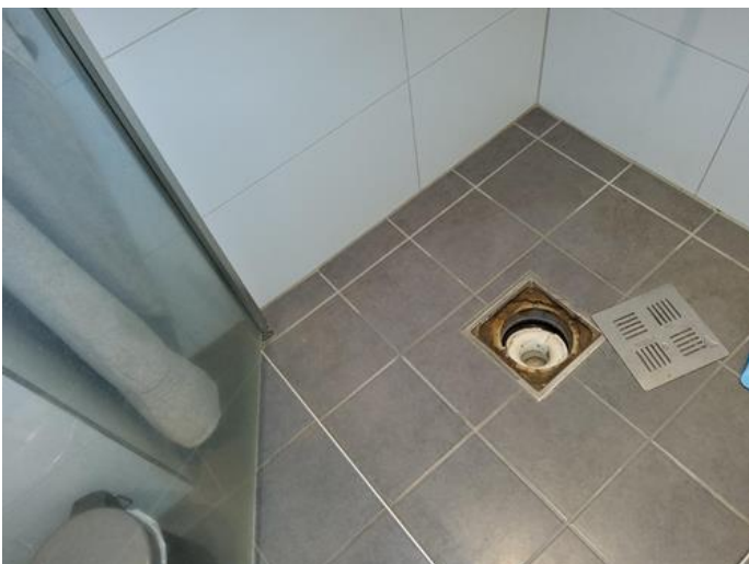
Membran, tettesjikt og overgang til sluk. - [Sluk]
