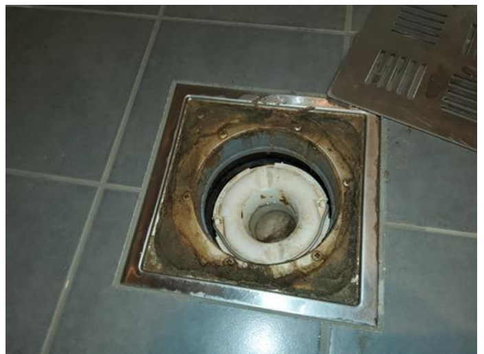
Membran, tettesjikt og overgang til sluk. - [Sluk]
